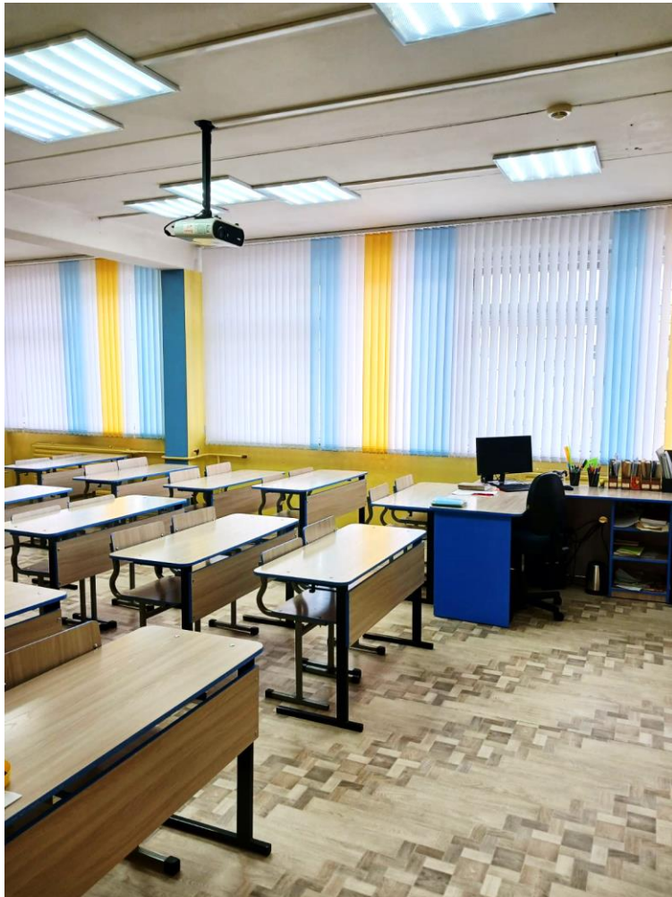
Кабинет №24 жалюзи , замена освещения
